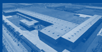
Hörmann Tianjin, Kína
